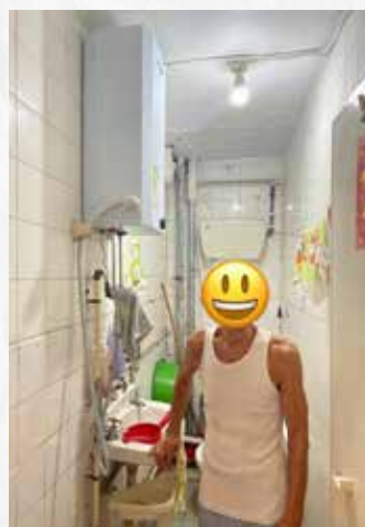
本社收到長者中心社工轉介一名獨居及體弱長者，因家中沒有熱水爐，本社為長者安裝電熱水爐，免卻日常生活中的不便。
